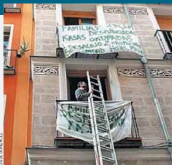
Varios ‘okupas’ han entrado en otro piso con esta escalera.
